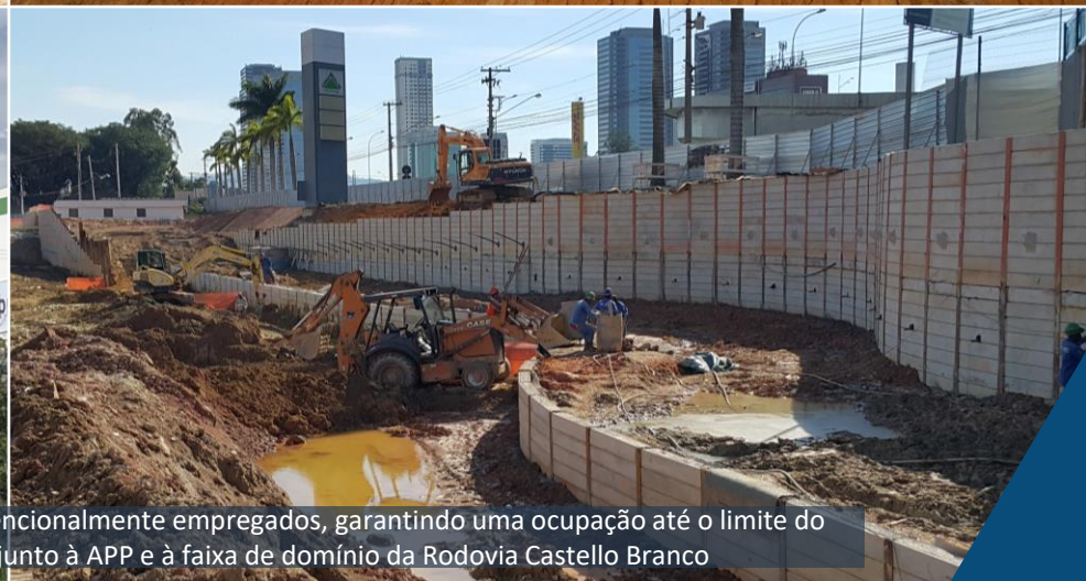
Arrimo de corte – Estacas metálicas cravadas e painéis pré-fabricados
