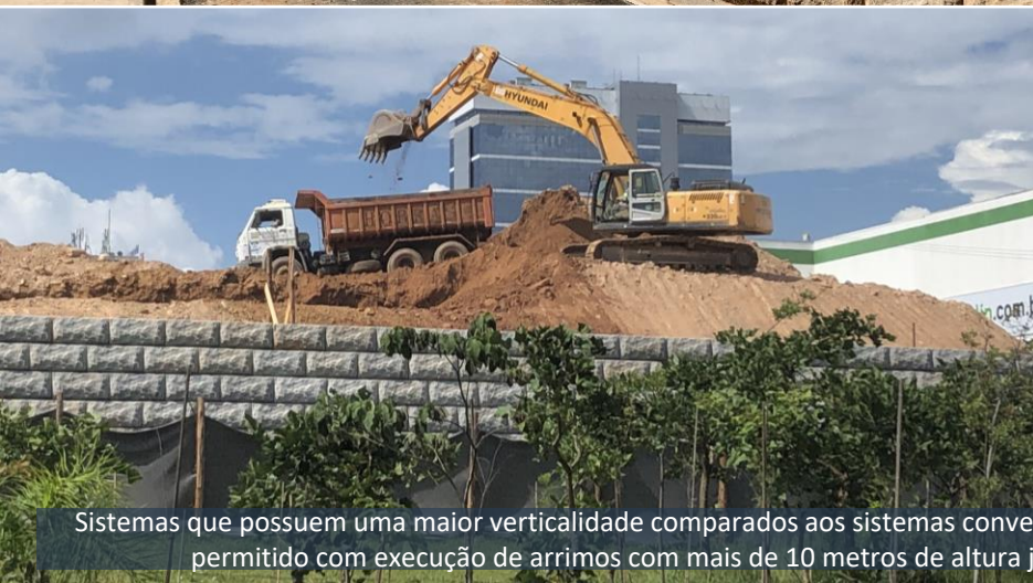
Arrimo de aterro – Sistema Lock & Load
